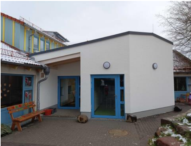
Der neue Anbau von außen
